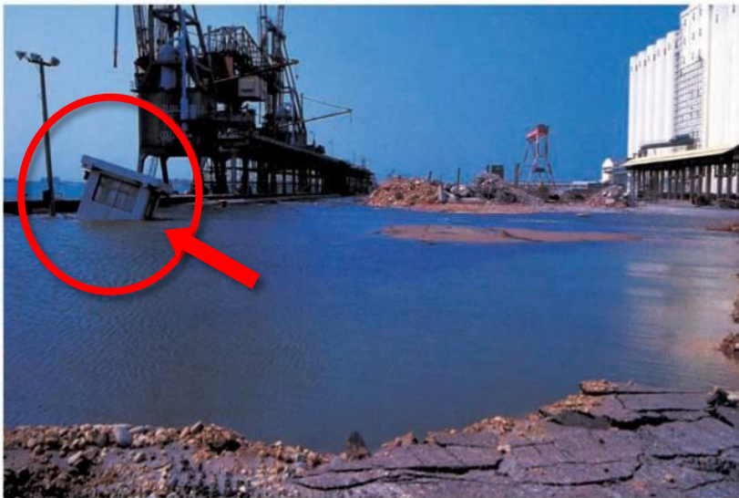
圖 7-19 集集地震在臺中港發生土壤液化、警衛亭傾倒（紅圈）。
